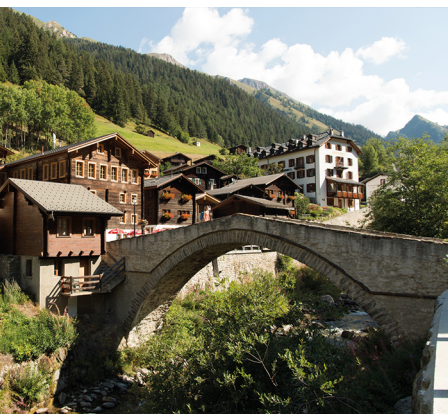
Brücke über die Binna in Binn Bild: Raja Läubl
