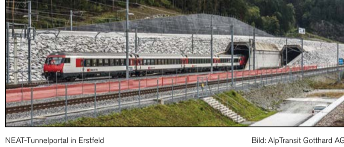
NEAT-Tunnelportal in Erstfeld Bild: AlpTransit Gotthard AG
