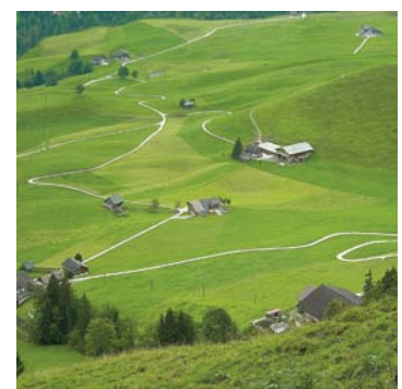
Punktueller Belagseinbauten ergeben mit der Zeit grössere Belagsstrecken.
