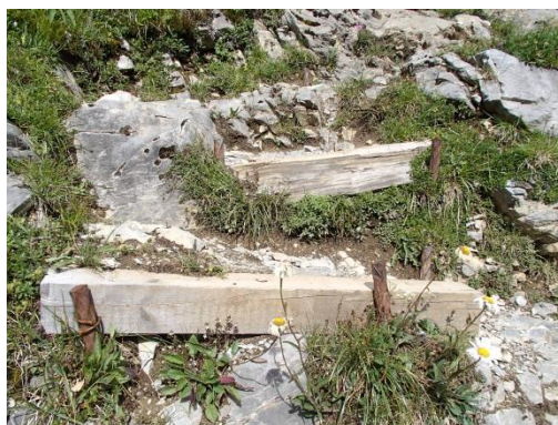
Des piquets mal enfoncés peuvent entraîner des chutes.
