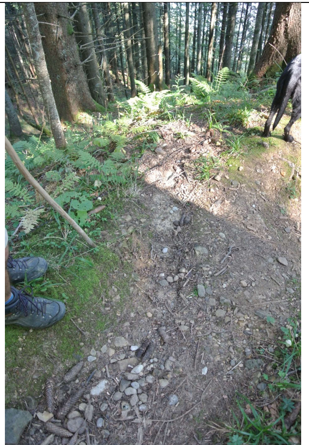
Abb. 4-18: Querabschlag zur Ableitung des Wassers in den Wald. Ausgehoben von Hans Ruedi Appert (Foto: R. Corrodi)
