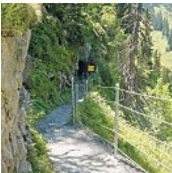
Fig. 61 Parapetto di metallo
