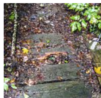
Fig. 93 Le foglie morte umide fanno marcire gli elementi in legno.
