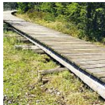
Fig. 53 Passerella su travi trasversali
