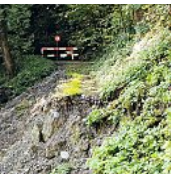
Fig. 92 Franamento del versante
