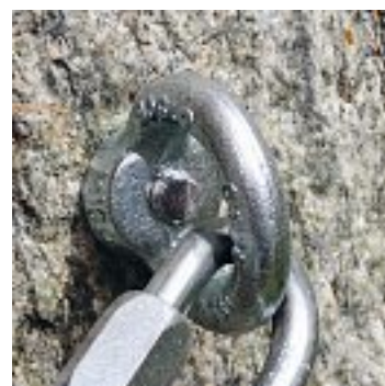
Fig. 65 Ancorare bene la catena
