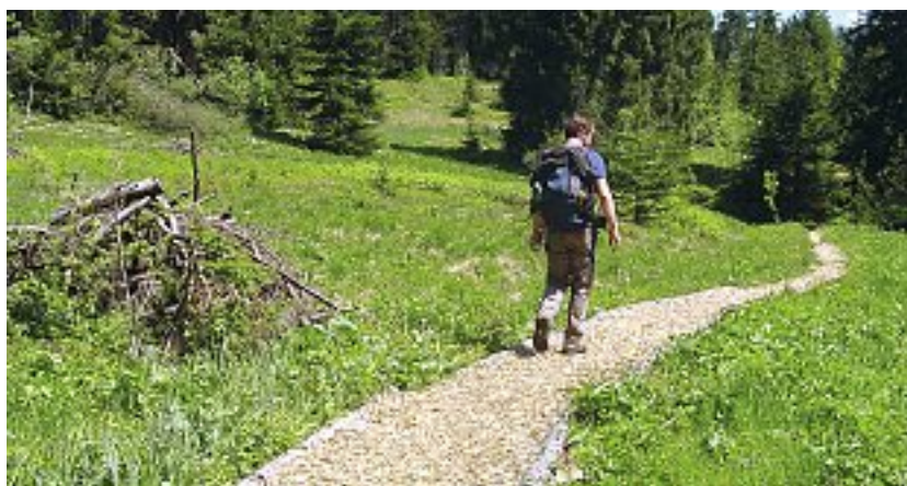
Fig. 19 Sentiero con strato di fondazione realizzato direttamente sul terreno naturale
