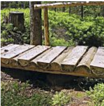
Fig. 50 Piano di calpestio realizzato in semitondame
