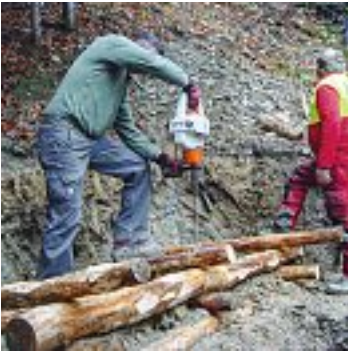
Fig. 79 Palificata di sostegno
