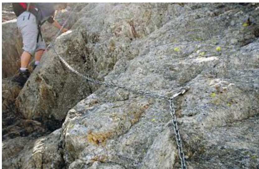
Fig. 63 Corrimano realizzato con una catena zincata
