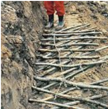
Fig. 75 Gradonata viva con ramaglia
