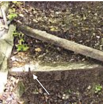
Fig. 86 Ferro di armatura sporgente
