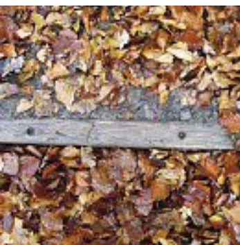
Fig. 56 Gradino con fori trapanati per il fissaggio dei ferri di armatura
