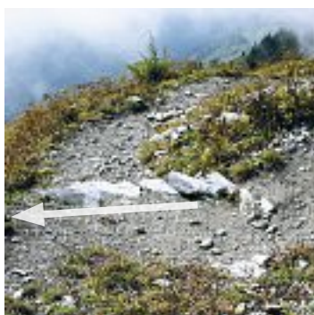
Fig. 26 Drenaggio nel punto di svolta
