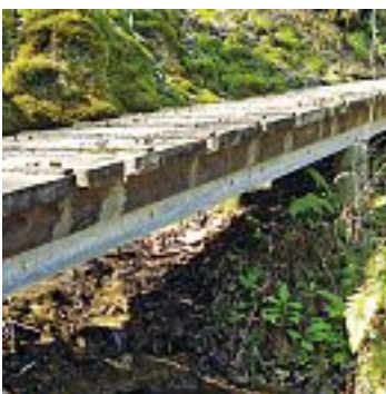
Fig. 51 Piano di calpestio realizzato con assi di legno segato grezzo
