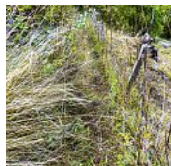
Fig. 94 Sentiero ostruito dalla vegetazione
