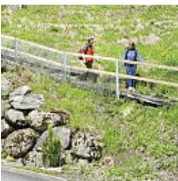
Fig. 62 Parapetto di legno
