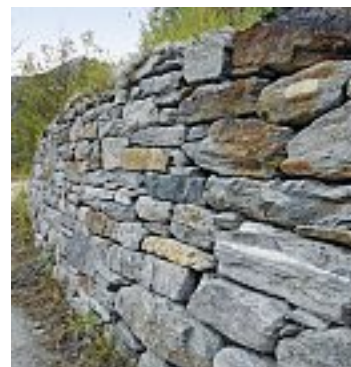
Fig. 82 Muro a secco
