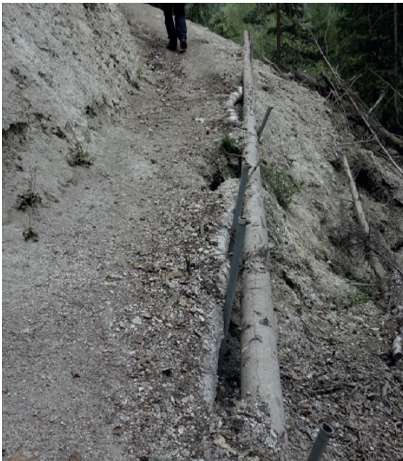
Chemin des Bisses, Grimentz-Vercorin: Erosionsschäden am Weg verursacht durch die intensive Nutzung von Mountainbikern.
