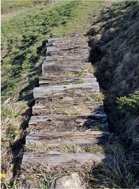
Obwaldner Höhenweg, Hüttstett-Hebrig: Zwischen den Standorten Hüttstett und Herbrig sind auf mehreren kürzeren Abschnitten vernässte oder morsche Prügel vorhanden.
